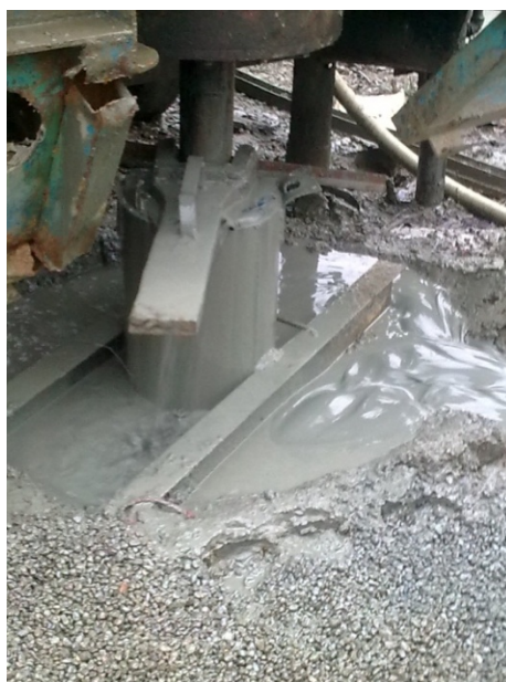
شکل ۳. شست‌وشو و تمیز کردن چاه
