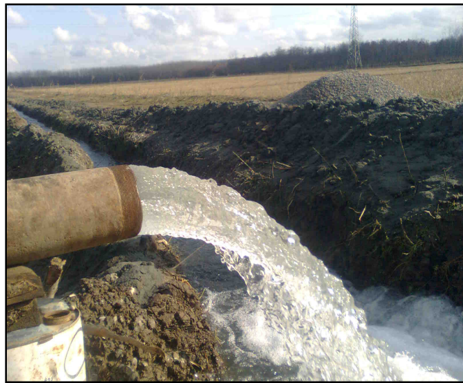
شکل ۴. عملیات توسعه چاه
