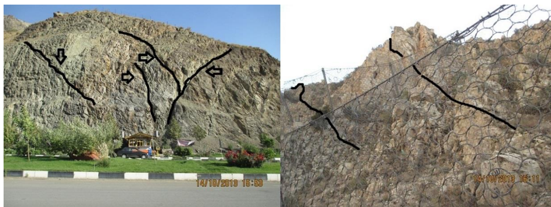
شکل ۲. گسل خوردگی بر روی سنگ‌های مقاوم (سمت چپ) و سنگ‌های خردشده و گسل خورده بر روی دامنه همراه با سازه‌های محافظتی ژئوتکستال (سمت راست)
