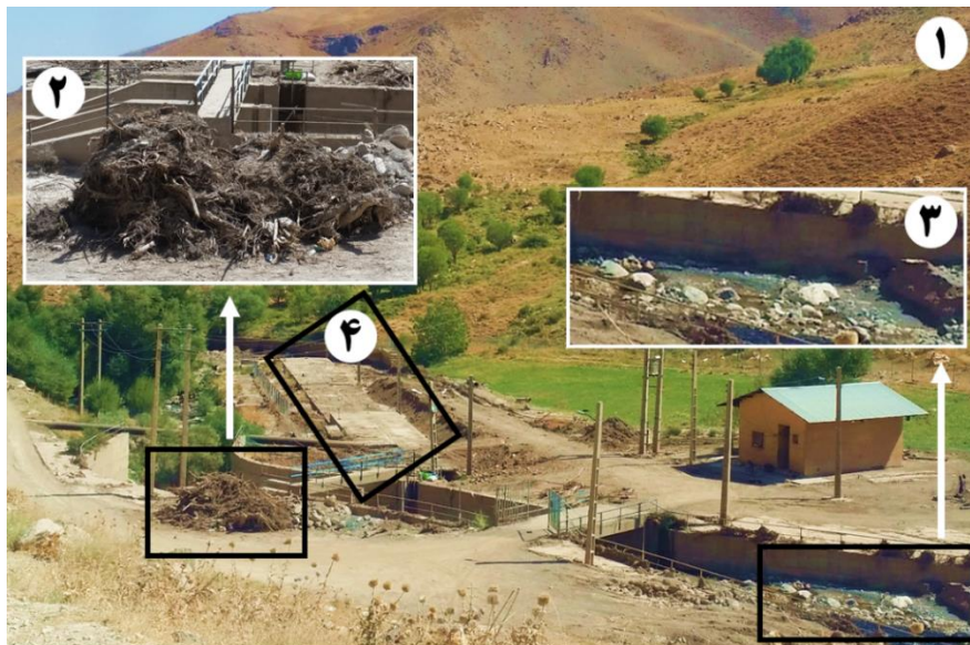
شکل ۱۰. تأسیسات انتقال آب به شهرهای الیگودرز و ازنا (۱) انباشت بقایای گیاهی و رسوبی پس از پاک‌سازی دریاچه (۲) ورود رسوبات درشت‌دانه ناشی از سیلاب واریزه‌ای به ابتدای کانال روباز (۳) کانال سرپیسته انتقال آب به شهرهای الیگودرز و ازنا (۴)
